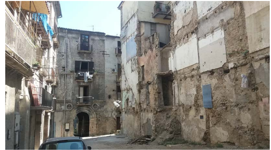
Fig. 7 Centro storico di Cosenza: si demolisce in nome della "pubblica e privata inciviltà" (foto L. De Falco)
