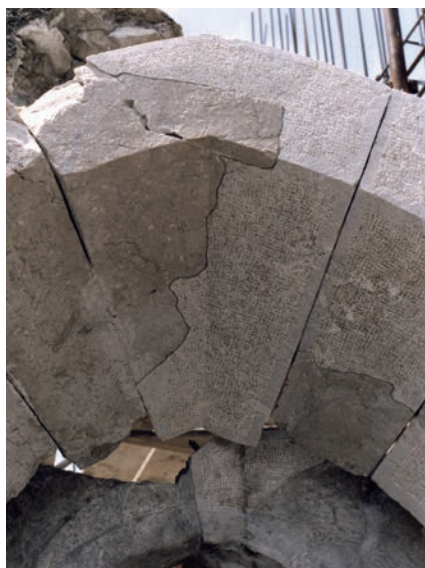
Fig. 10 – Esempio della diversificazione dei restauri sui conci danneggiati del Duomo.
