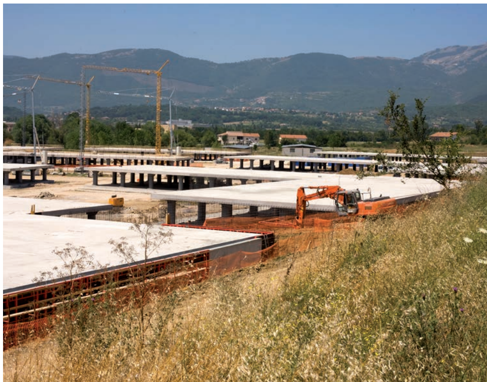
Fig. 16 – Piastre di fondazione del Progetto CASE.
