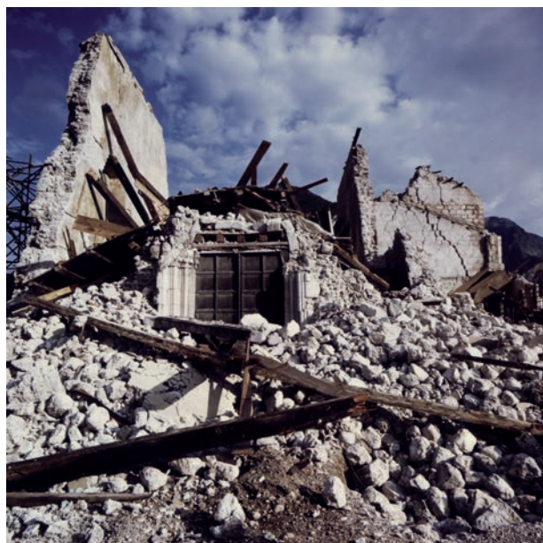
Fig. 7 – Il Duomo di Venzona dopo il terremoto del 15 settembre 1976:
