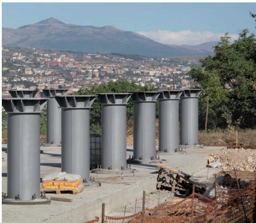
Fig. 17 – Pilastrini con isolatori sismici di un intervento del Progetto CASE.
